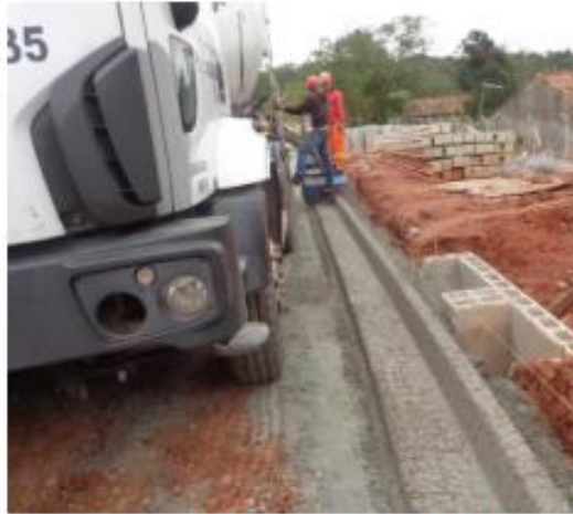
Figura 1 - Execução de guia e sarjeta com máquina extrusora
