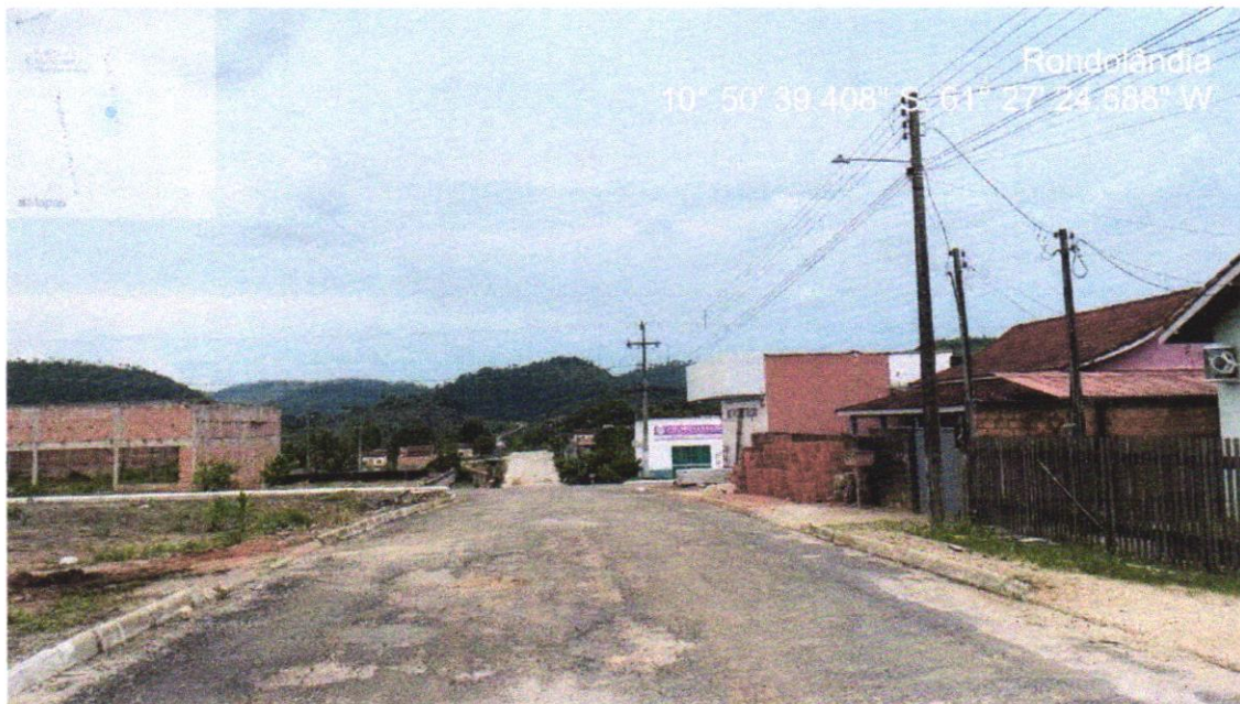
IMAGEM 30 RUA PEDRO MOREIRA ENTRE (AV JOANA ALVES DE OLIVEIRA / RUA RIO MADEIRA)
