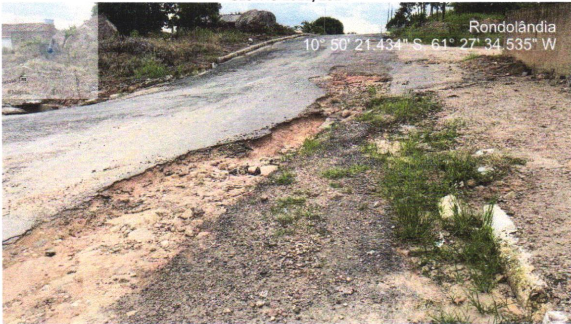
IMAGEM 40 - RUA SURUI ENTRE AV DOM BOSCO / RUA JAIME FREIRE
