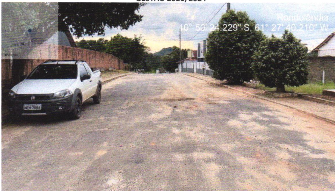
IMAGEM 44 - RUA SURUI ENTRE AV DOM BOSCO / RUA JAIME FREIRE
