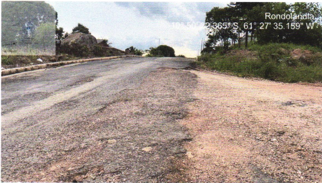
IMAGEM 39 – RUA SURUI ENTRE AV DOM BOSCO / RUA JAIME FREIRE
