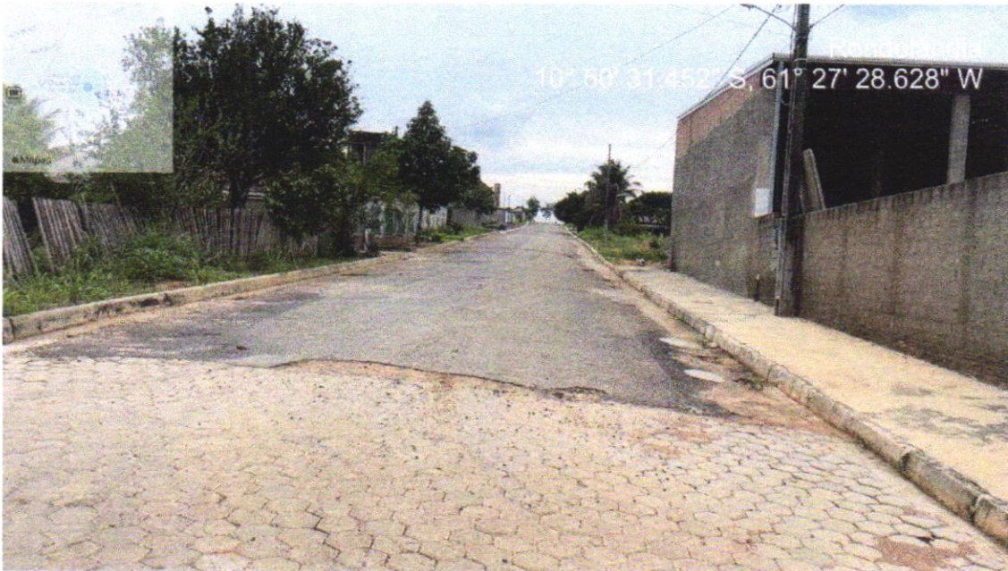
IMAGEM 23 – RUA JOSÉ RAIMUNDO DA SILVA ENTRE (AV ANDRÉ MAGGI / AV JOANA ALVES)
