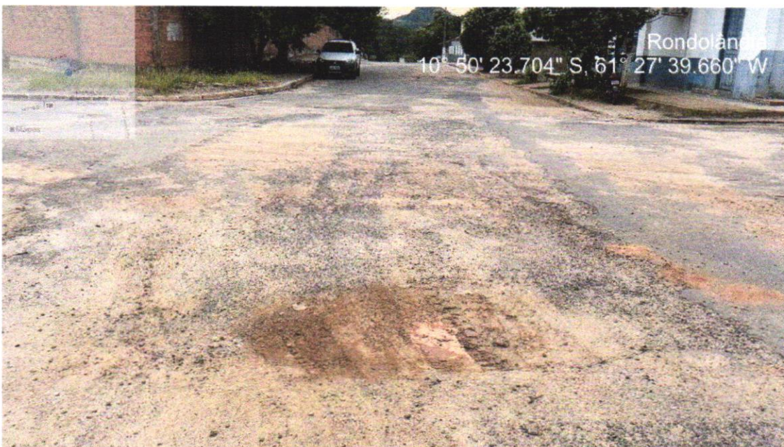
IMAGEM 43 - RUA SURUI ENTRE AV DOM BOSCO / RUA JAIME FREIRE
