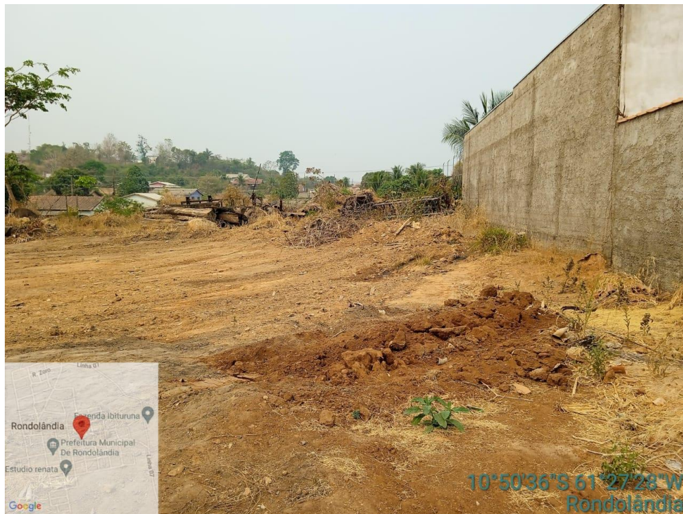
IMAGEM DO LOCAL DA CONSTRUÇÃO – RUA JOSÉ RAIMUNDO DA SILVA ESQ COM RUA RIO BRANCO (COORDENADAS: 10°50'35” – 61°27'27”)
