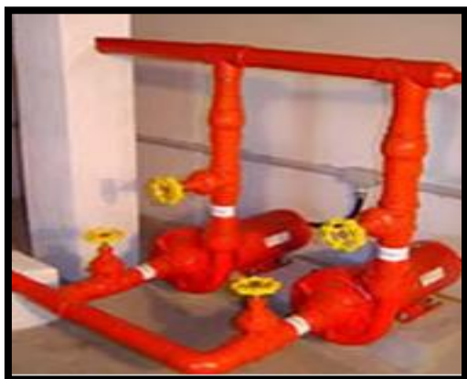
Figura 16 - Bomba de Incêndio
