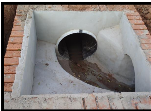
Figura 1. Execução do fundo das caixas de passagem
