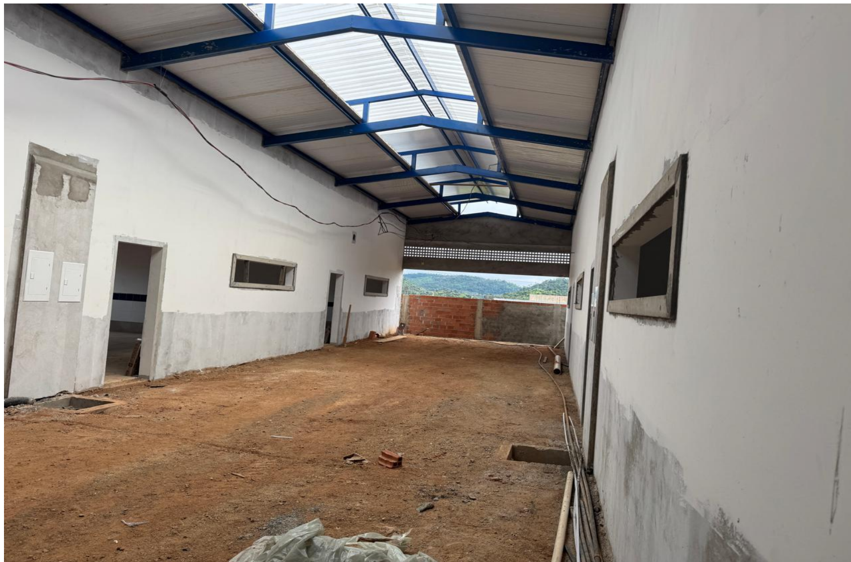
Escola Municipal obras em andamento - figura 3
